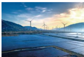
貯蔵設備・発電設備
