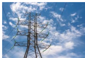
変電所・変圧器・制御盤
