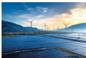
貯蔵設備・発電設備
