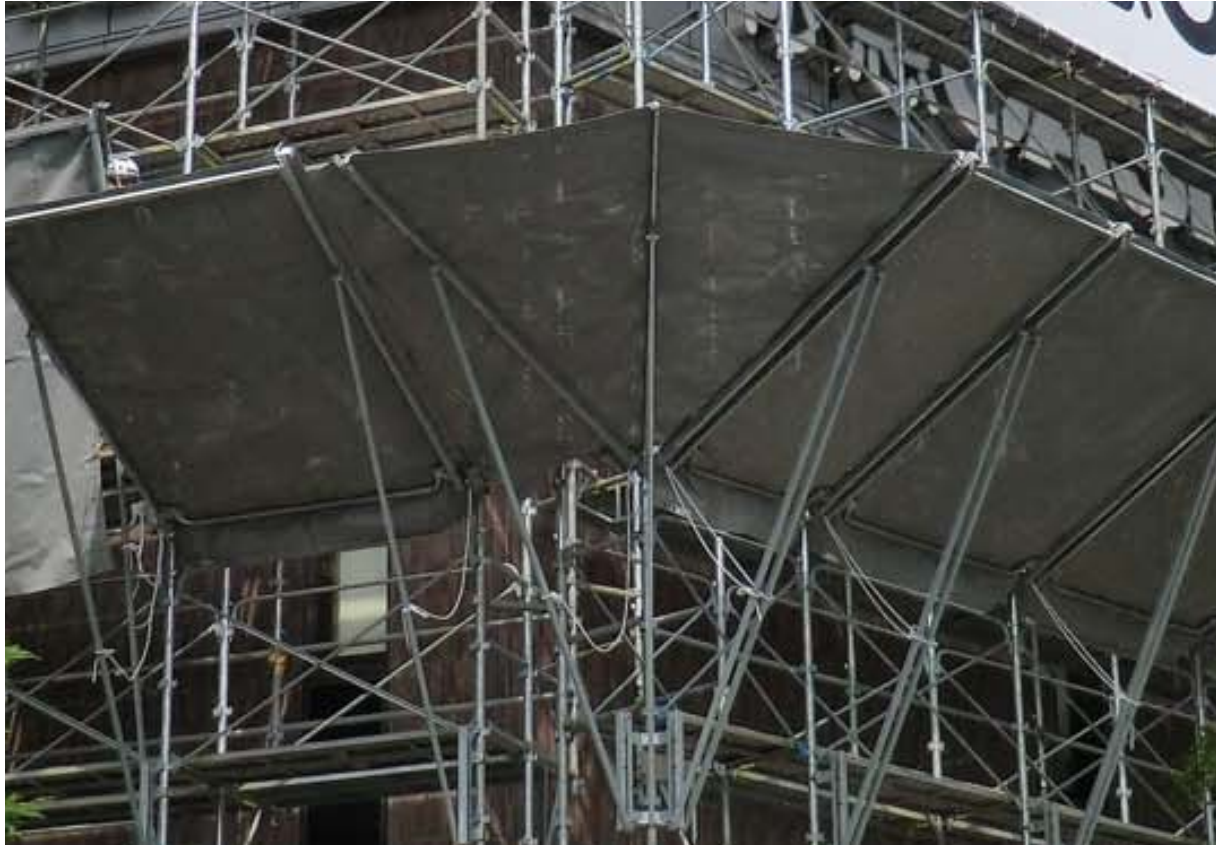
複雑なコーナー部も足場内ですべての作業ができます
