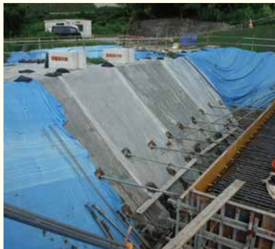
「エースシート」と、ブルーシートを併用して法面に設置した状況。中央の透明な部分では中の様子が一目でわかる
