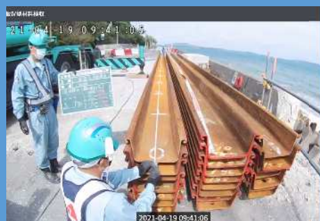
材料確認 現場
