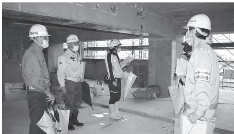
県営大謝名団地建設現場を訪問
