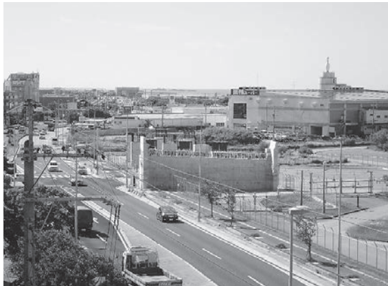
小禄道路（橋梁下部工）
